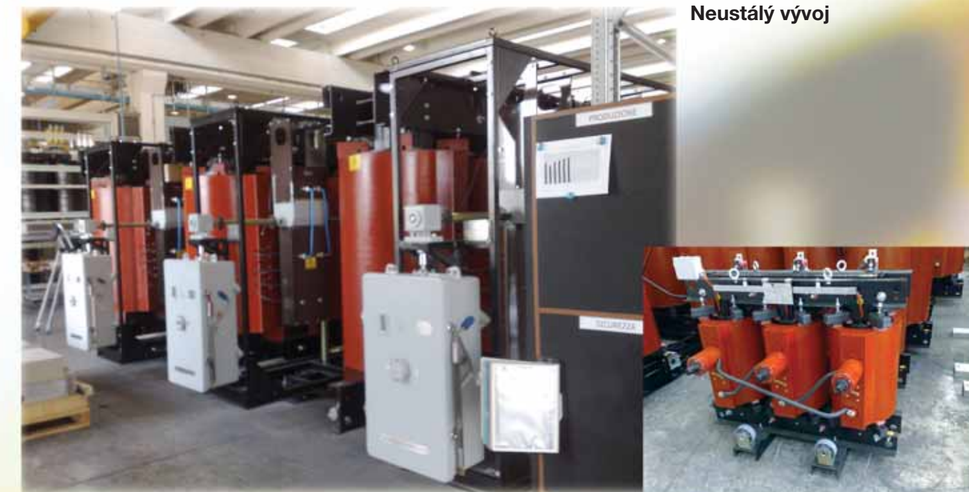
Transformátor 8MVA s přepínačem pod zátěží
